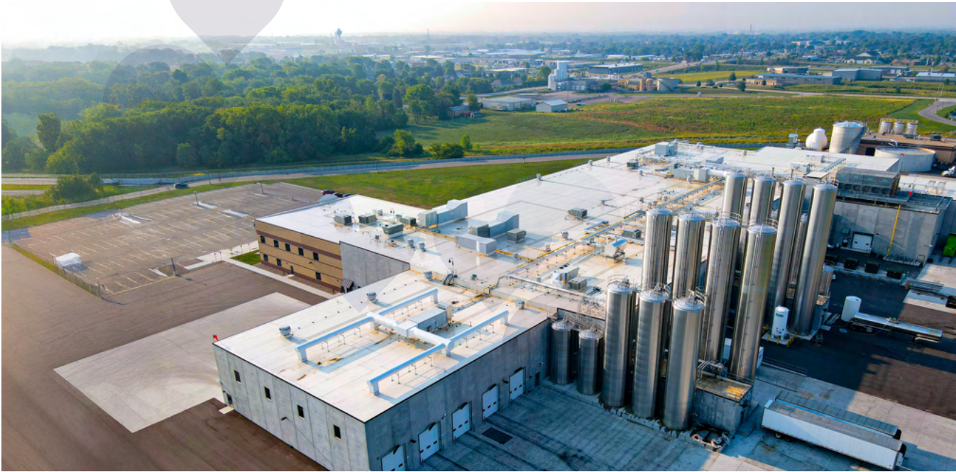
Usine d’Agropur Little Chute, Wisconsin
